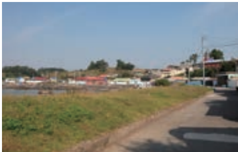
도로확장 공사로 없어진 노인정 앞 바닷가 집수시설
